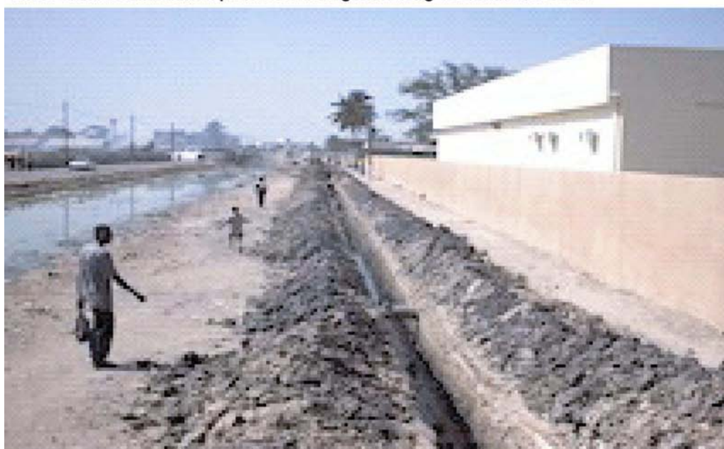
Photo III.3.2 : Canalisation pour réseau d'égout le long du Canal de l'Ouest
