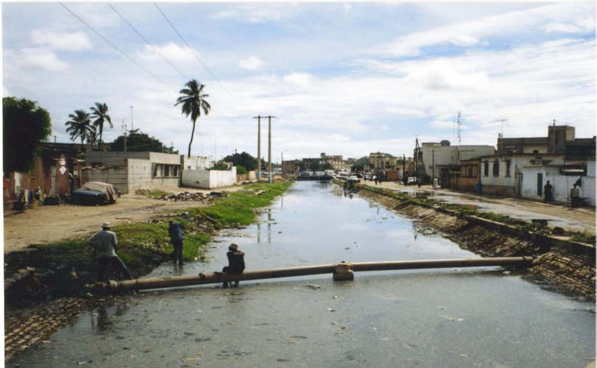
Photo III.1.1 : ouvriers curant le Canal de l'Ouest
