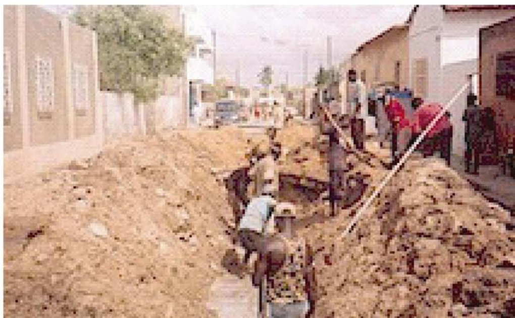
Photo III.3.1 : Canalisation pour réseau d'égout dans le quartier de Diokoul
