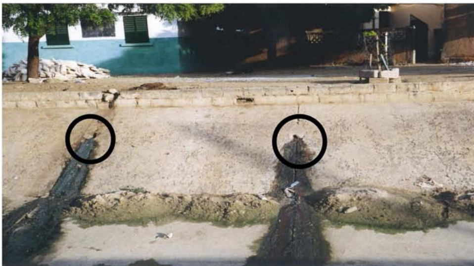
Photo III.2.3 : Tuyaux de fosses connectés directement au Canal de la Ceinture
