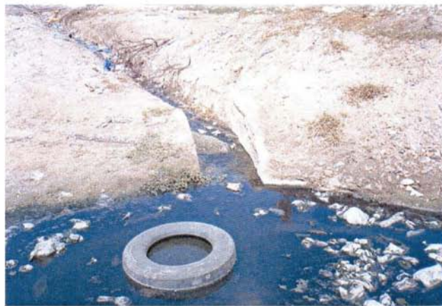
Photo I.2.12 : Eaux usées et ordures dans le canal de Guendel
