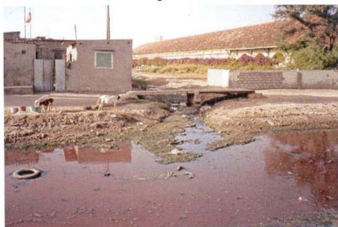
Photo I.2.9 : Eaux usées stagnantes dans le canal de l'Ouest
