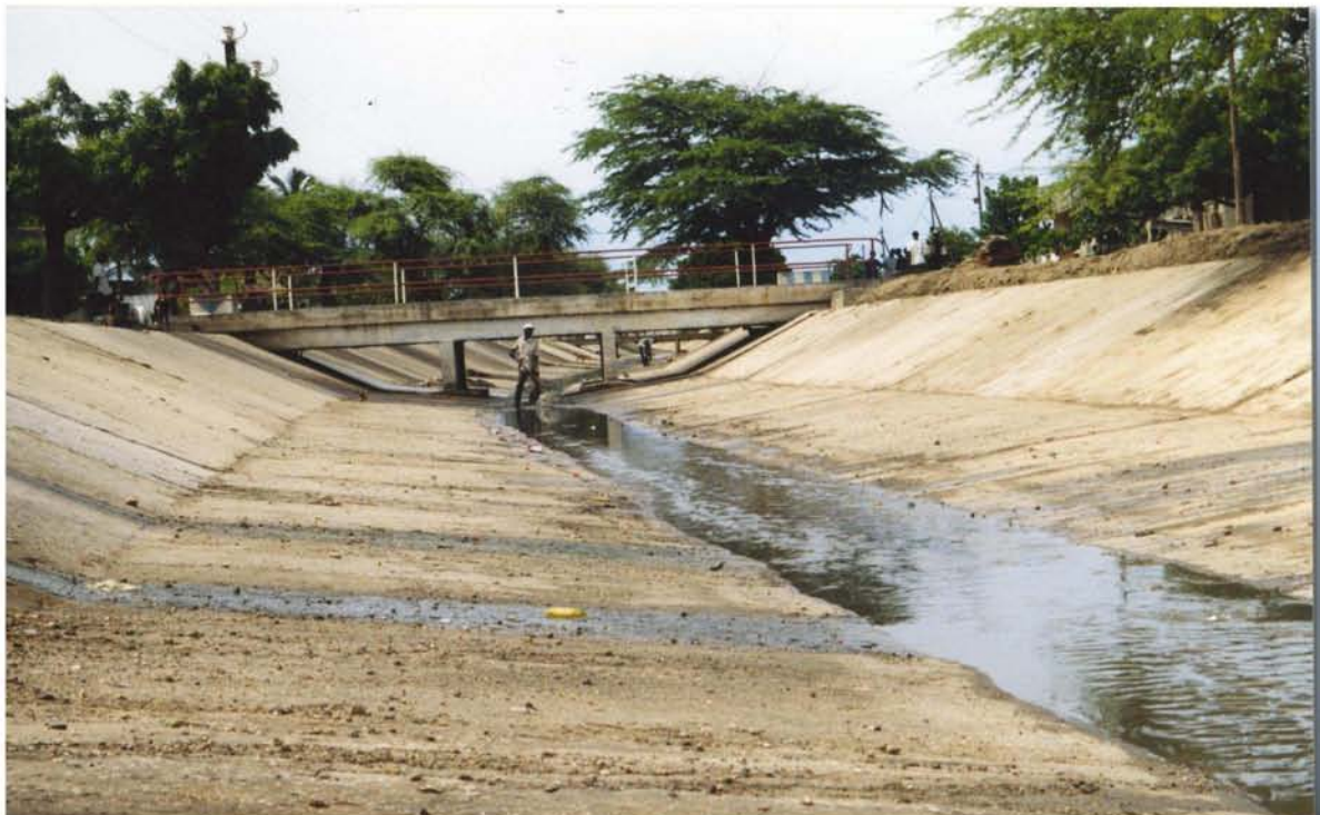
Photo III.1.2 : curage du Canal de la Ceinture
