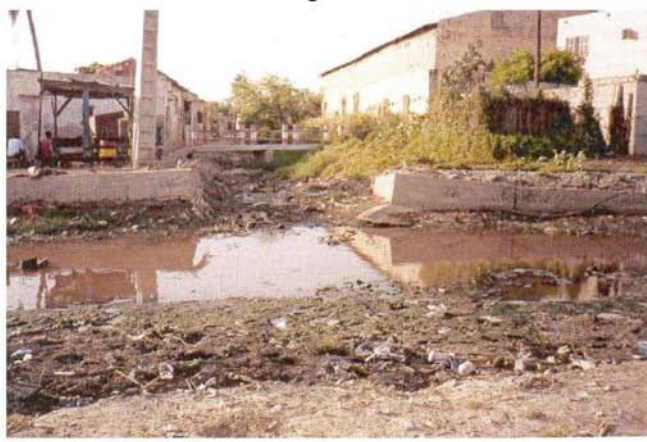
Photo I.2.10 : Eaux usées stagnantes dans le canal Rivoli
