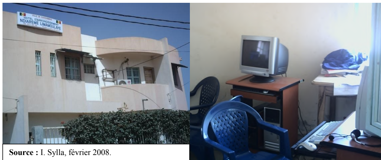
Planche 12 : Vues du bâtiment de la mairie de Ndiarème Limamoulaye et du cyber municipal de cette ville
