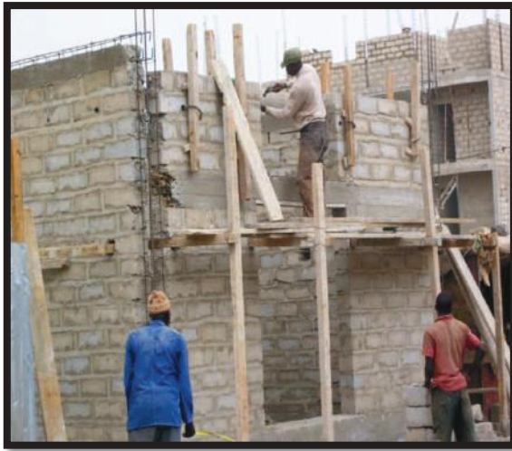
Photo 5 : Maçon sur un échafaudage en bois à Keur Massar (Pikine)
