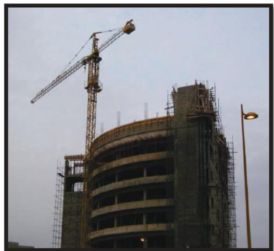
Photo 12 : Echafaudage mécanique à Dakar (centre-ville)
